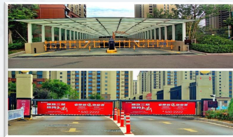
停车场出入口管理系统
