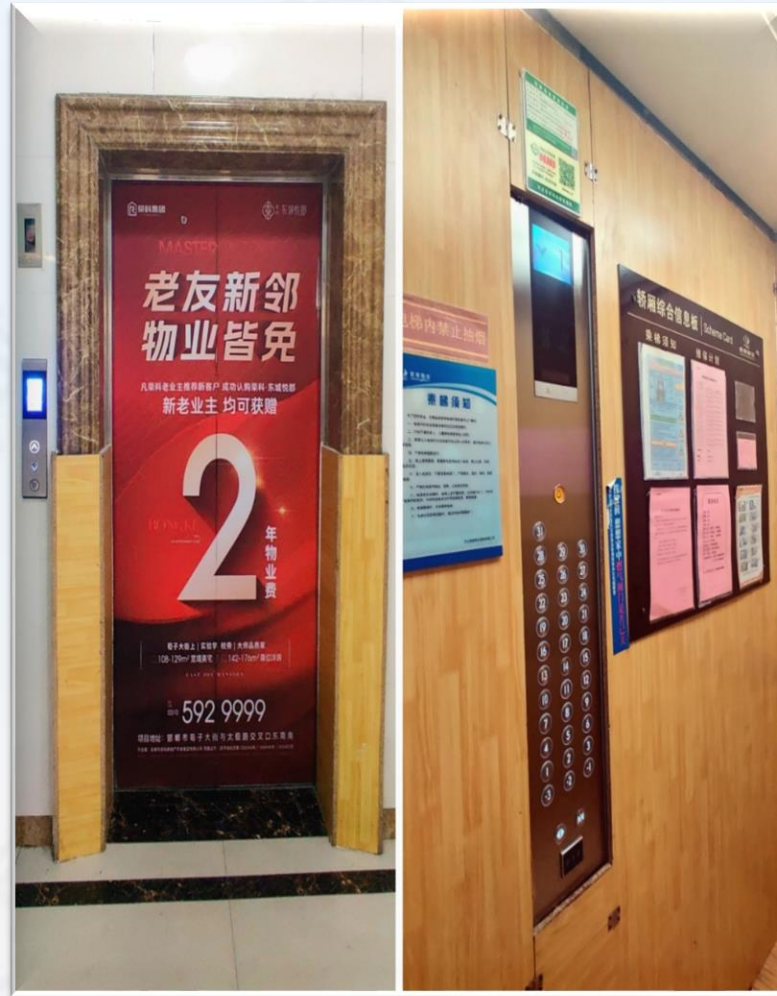
电梯控制系统
