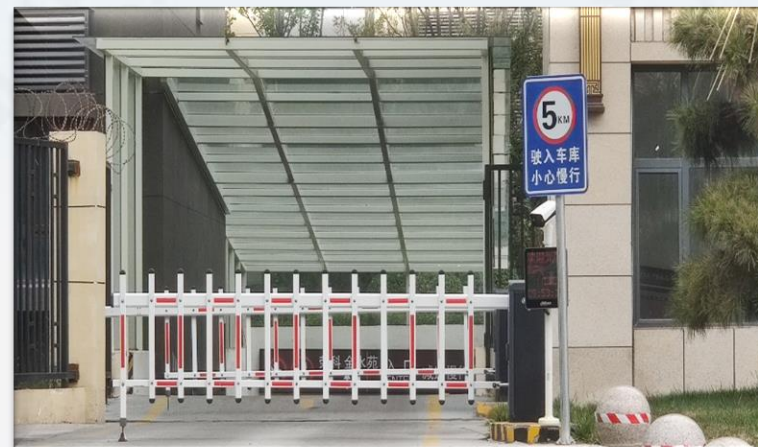
停车场出入口管理系统
