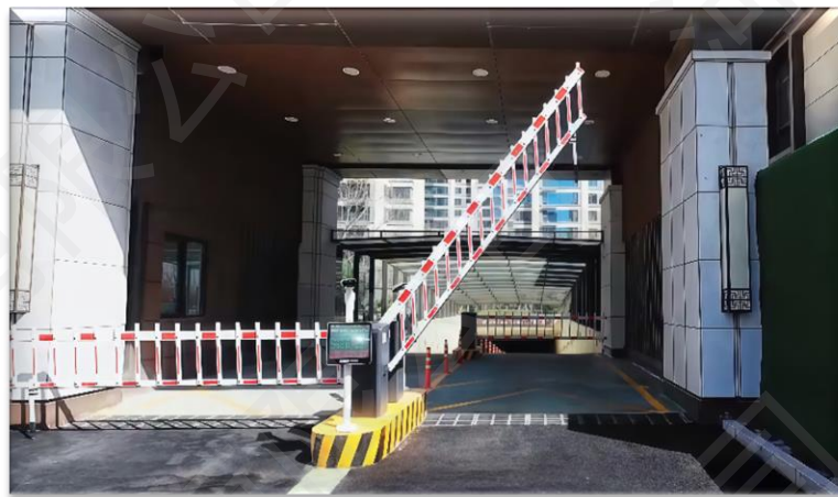
停车场出入口管理系统
