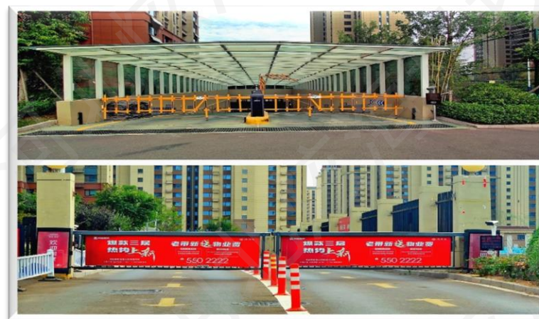
停车场出入口管理系统
