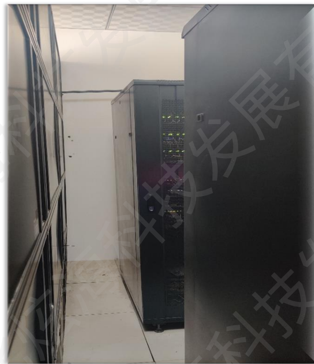
服务器机柜和UPS电源
