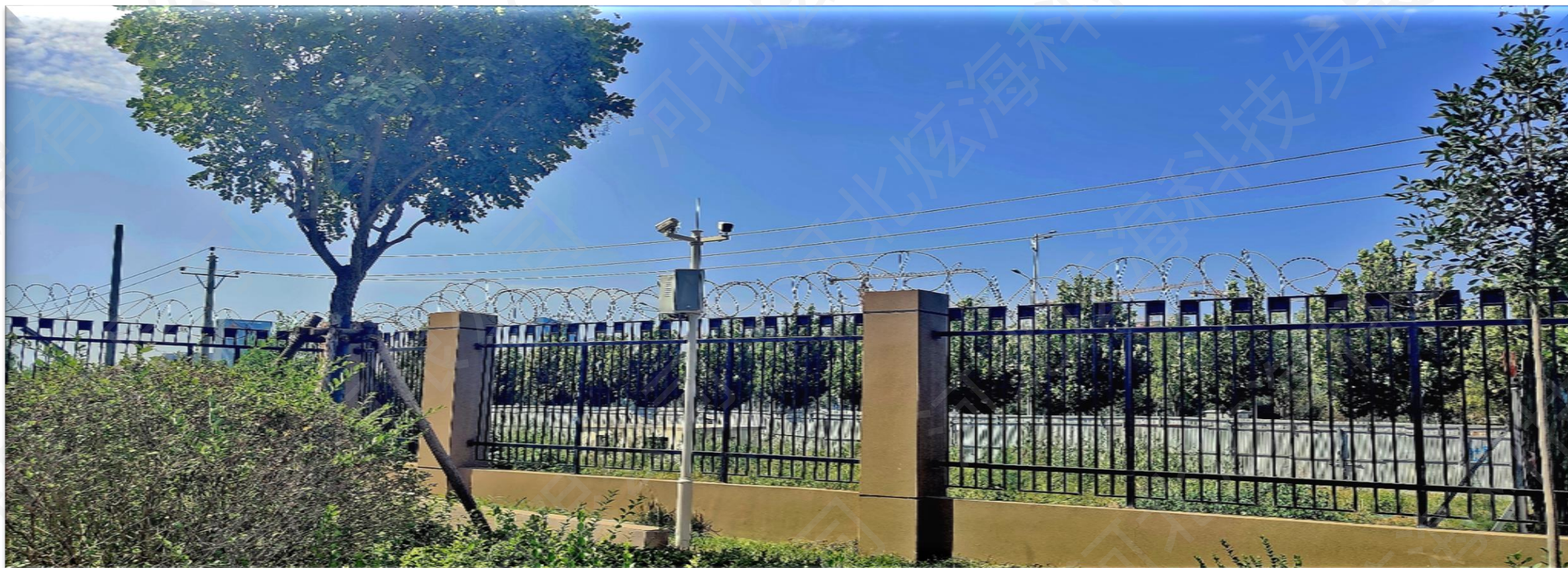
园区围墙的周界监控
